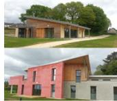
Chaudière bois granulés avec petit réseau de chaleur, solaire thermique, solaire photovoltaïque (150m<sup>2</sup>), VMC DF, murs en paille
