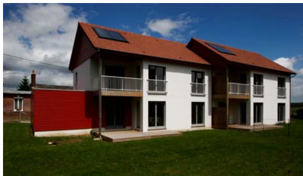
Figure 1. Vue des maisons étudiées (Arch.: En Act architecture)
