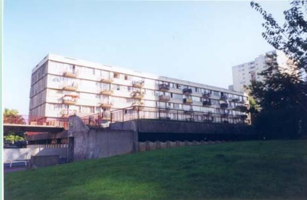
*Construction : 1969, non isolé, simple vitrage*
