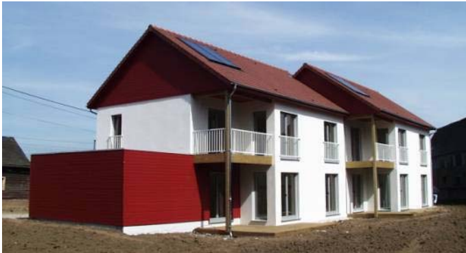
Maisons passives à Formerie (Oise), Entreprise Les Airelles Construction
